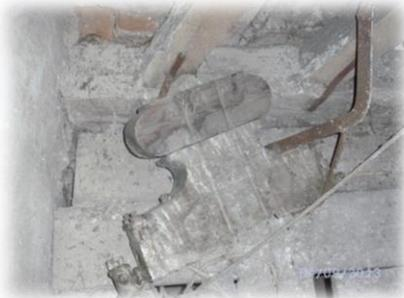
Beim Projekt 2 „Erneuerung der Klöppel und Jochsanierung Glocke 3“ starten die Arbeiten in ca. 4-8 Wochen, da die neuen Klöppel erst speziell für unsere Glocken angepasst und erzeugt werden. Ebenfalls wird das bestehende Holzjoch (Foto links) von Glocke 3 saniert und in diesem Zuge auch gleich wieder eingebaut werden.
