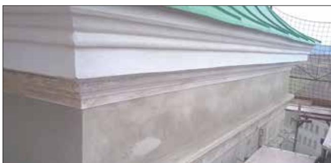
Die teilweise stark beschädigten Gesimse wurden gefestigt, lockere Teile abgeschlagen und fehlende ergänzt.
