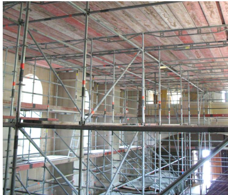
Im zweiten Bauabschnitt (B) ist die Herstellung eines Stahlrahmens auf der Innenseite beider Türme in ca. 22 m Höhe, deren Verankerung im Turmmauerwerk und die Abspaltung bis in den Sockelbereich, sowie die Instandsetzung des Innenputzes geplant.
