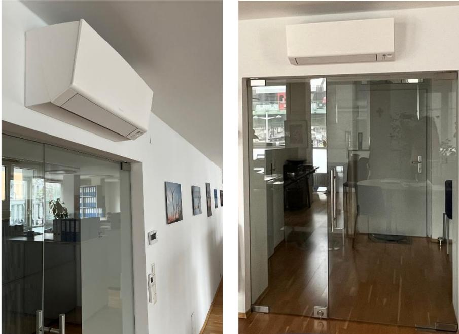
**Moderne Klimaanlage können ihren Kreislauf auch umkehren und dann als Wärmepumpe zum Heizen verwendet werden.**
