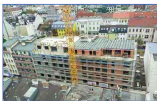
Baustelle vom Krahn her gesehen am 2.05.2023
