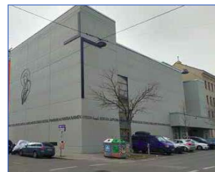
Pfarrkirche nach der Sanierung
