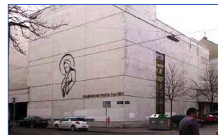
Pfarrkirche vor der Sanierung
