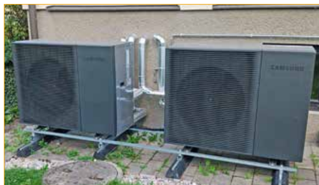
Der Ölkessel wich der Luft-Wärmepumpen-Anlage.
