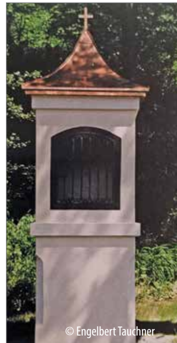
Frontansicht des Marterls im Ziegelofen nach seiner Errichtung im Jahr 1999.
