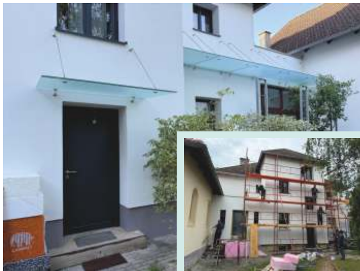
Neue Fassade, Vordächer Fotos: Christian Pohanka
