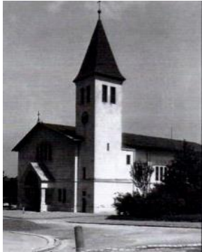
Notkirche von außen 1905. (Hans W. Bousska, Wien 12 – Meidling. Ein Bildbogen, 2021, S. 18.)
