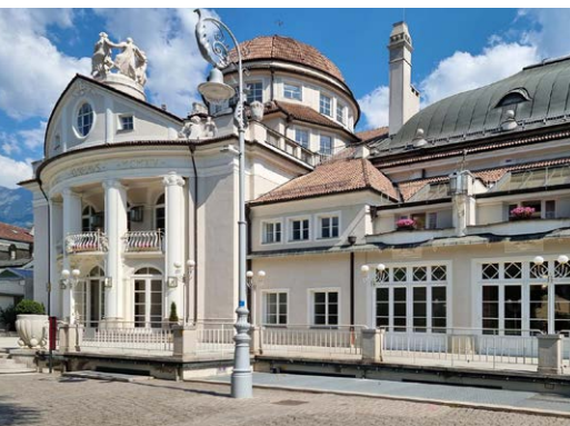
Thermenanlage in Meran
