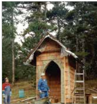
Beim Bau im Jahr 1995
