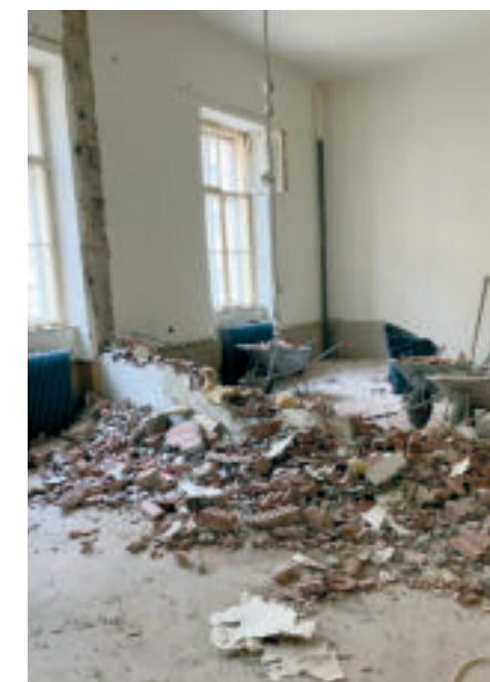
Neue Türöffnungen wurden gemacht und Wände wurden niedrigerissen.
