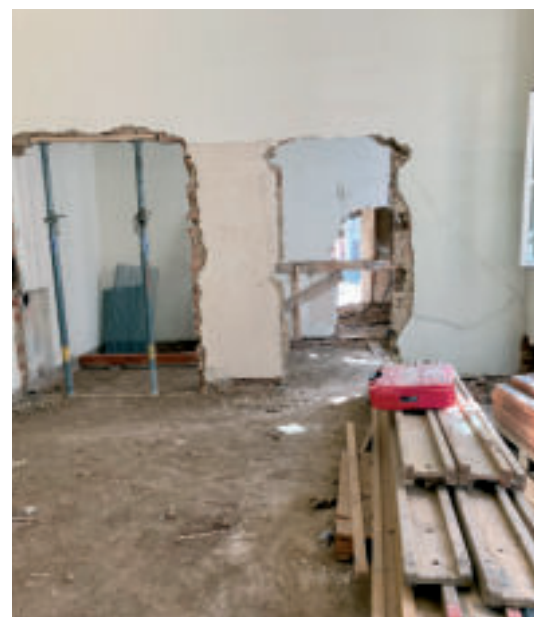
Neue Türöffnungen wurden gemacht und Wände wurden niedrigerissen.
