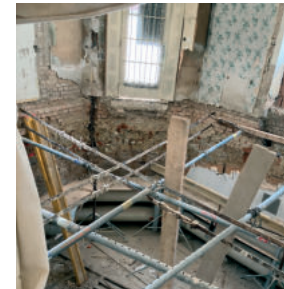
Für einen barrierefreien Eingang muss die Decke abgesenkt werden.
