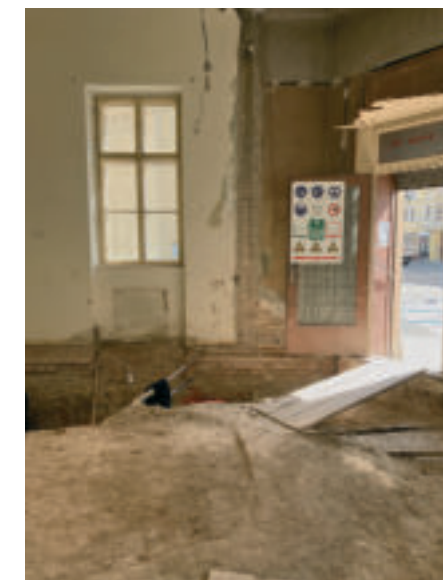
Für einen barrierefreien Eingang muss die Decke abgesenkt werden.
